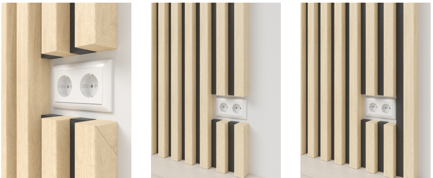
Фото 3. Пример обхода розетки во время монтажа с использованием запила под 45°
